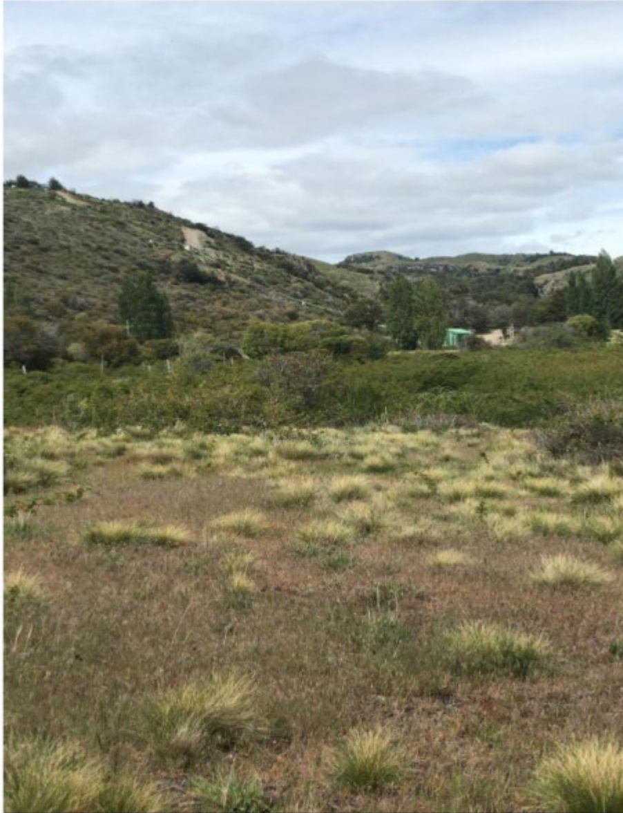
Fuente: Fotografía tomada por don Cristóbal Weber Mckay, el 9 de noviembre de 2022. Vista desde su domicilio a las obras del proyecto hidroeléctrico Los Maquis de Edelaysén S.A.
